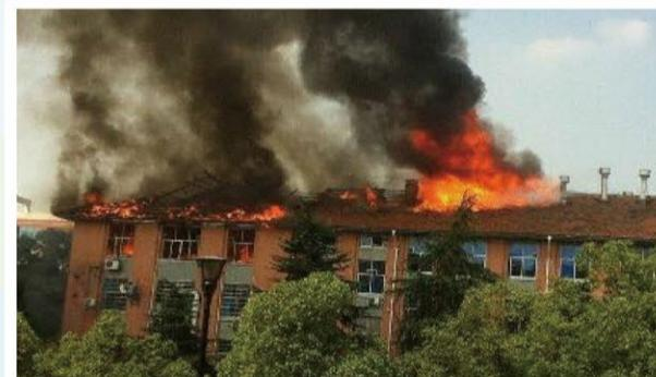
**事故原因：**实验室西侧操作台有漏水现象，未将遇水自燃试剂放置在符合安全条件的存储场所，对遇湿易燃物品管理不严。
